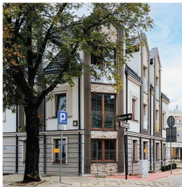
W budytku przy ul. Sienkiewicza 44 we wrześniu bieżącego roku zamieszka 15 rodzin.
