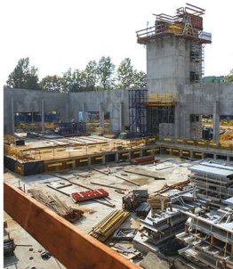
Aktualnie powstaje konstrukcja obiektu.
