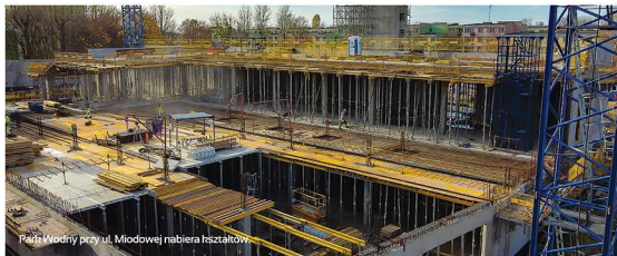
Plac Wodny przy ul. Miodowej nabiera kształtów.
